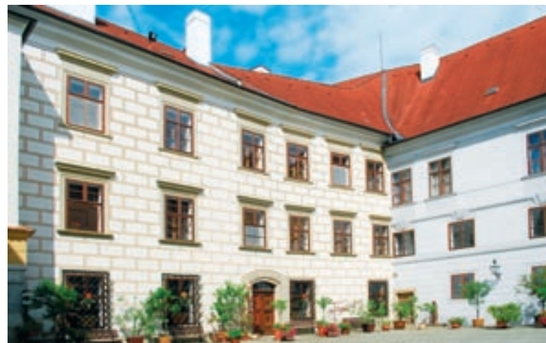
Severozápadní nároží vnitřního nádvoří zámku v Třeboni, kde probíhaly stavební úpravy za vlády Janova otce Voka II. a mladšího bratra Jindřicha VII. Razantní renesanční dostavba a úprava zámku v druhé polovině 16. století tyto stavební zásahy překryla nebo zničila.
